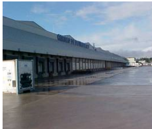
Centro de Distribuição
